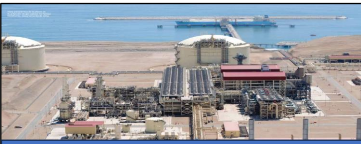
Terminal Portuario – MELCHORITA PERU LNG
